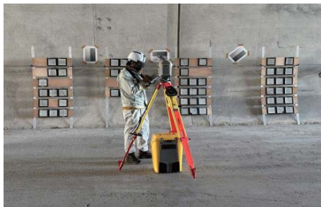
計測機器の設置、計測範囲等の設定
