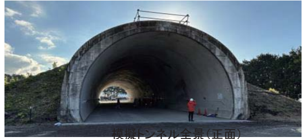
模擬トンネル全景(正面)
